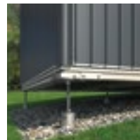
Niwelacja za pomocą wkrętów gruntowych
