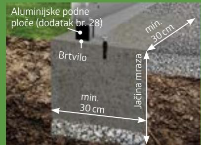
Druga mogućnost za podizanje vrtnih ostava na neravnom tlu je istočkani temelj u kombinaciji s **aluminijskim podnim okvirom**.
