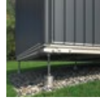
Höhenausgleich mit Erdschrauben
