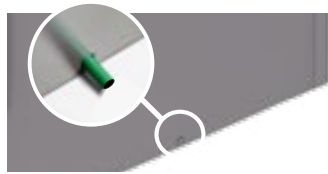
02 Vorbereitung für Bewässerung
