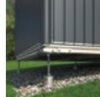
Ajustare a inaltimii cu suruburi de fixare
