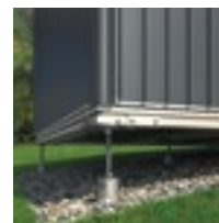
Højdejustering med jordskruer
