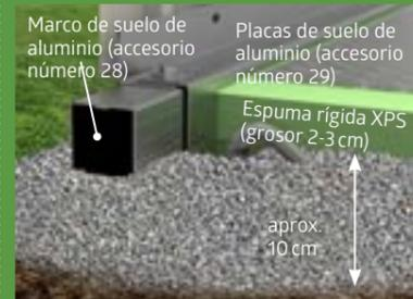
Con el **marco de suelo de aluminio**, también puede instalar y anclar la caseta en un lecho de grava (anclajes de suelo disponibles como accesorio). La **placa de suelo de aluminio** (accesorio) sirve como suelo funcional y se apoya en placas de espuma rígida XPS (no incluidas en el suministro).
