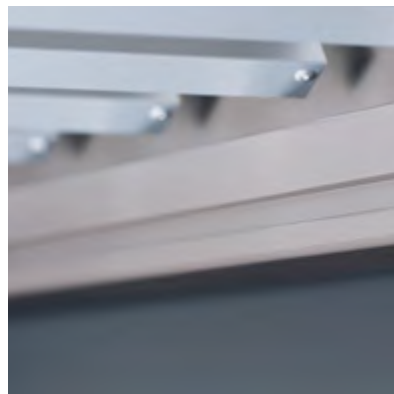
03 voorbereiding voor LED-verlichting (kanaal met afdekking)
