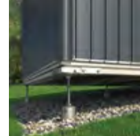
Hoogtecompensatie met grondschroeven
